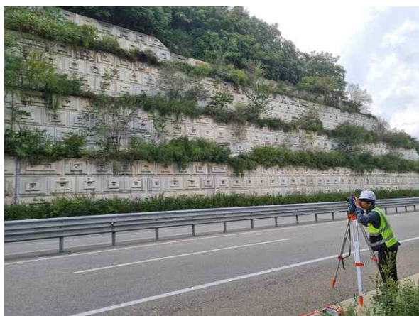
광파기를 이용한 측량 작업
